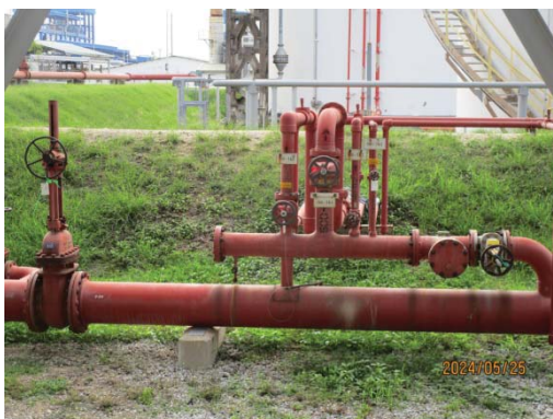
รูปที่ 3.1-1 (รูปที่ 76 Water Hydrant)
