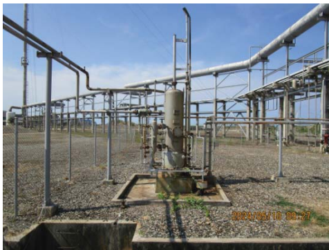
รูปที่ 3.1-1 (รูปที่ 2 ระบบกำจัดไอสาร ไฮโดรคาร์บอน (Vapor Disposal System))
