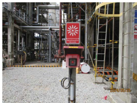
รูปที่ 3.1-1 (รูปที่ 66 Manual Call Point)
