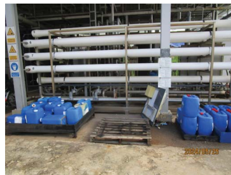
รูปที่ 3.1-1 (รูปที่ 28 ระบบ UF&RO)
