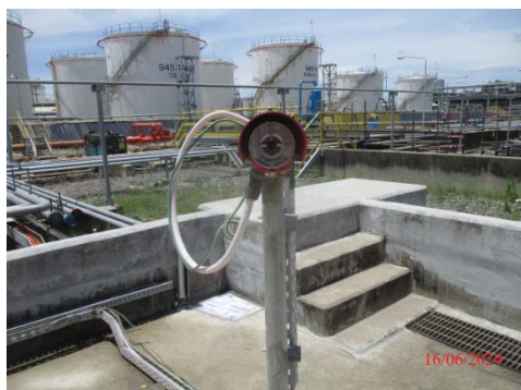
รูปที่ 3.1-1 (รูปที่ 65 Gas Detector บริเวณถังเก็บสำรอง)
