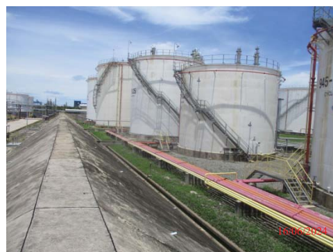
รูปที่ 3.1-1 (รูปที่ 62 คันกั้นล้อมรอบ ถังเก็บสำรอง)
