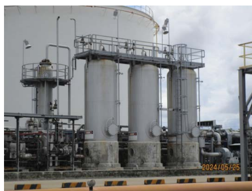
รูปที่ 3.1-1 (รูปที่ 8 Vapor Recovery Unit)
