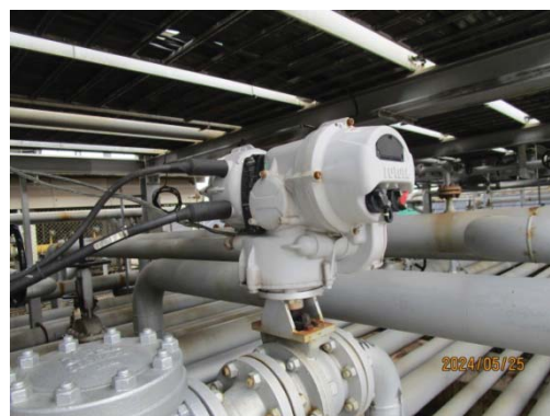
รูปที่ 3.1-1 (รูปที่ 91 On-Off Valve)
