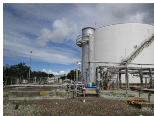
รูปที่ 3.1-1 (รูปที่ 6 ระบบกำจัดไอสาร ไฮโดรคาร์บอน (Vapor Disposal System) บริเวณลานถังเก็บกัก)
