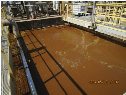
รูปที่ 3.1-1 (รูปที่ 23 Aeration Tank)
