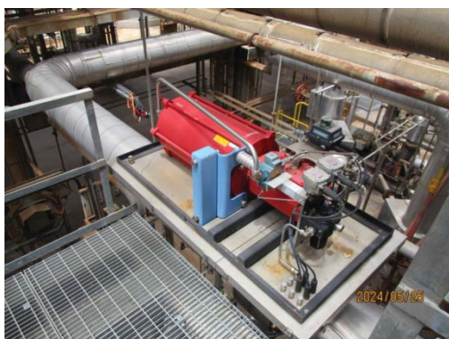
รูปที่ 3.1-1 (รูปที่ 91 On-Off Valve)
