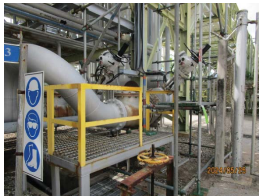
รูปที่ 3.1-1 (รูปที่ 94 วาล์วตัดแยกระบบ)
