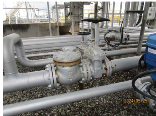
รูปที่ 3.1-1 (รูปที่ 93 Check Valve)
