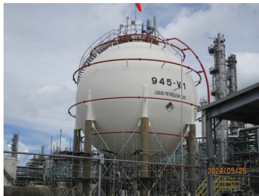
รูปที่ 3.1-1 (รูปที่ 85 ระบบฉีดพรมน้ำ บริเวณถังเก็บสารอง)
