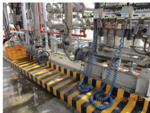
รูปที่ 3.1-1 (รูปที่ 71 Grounding บริเวณ Loading Rack)
