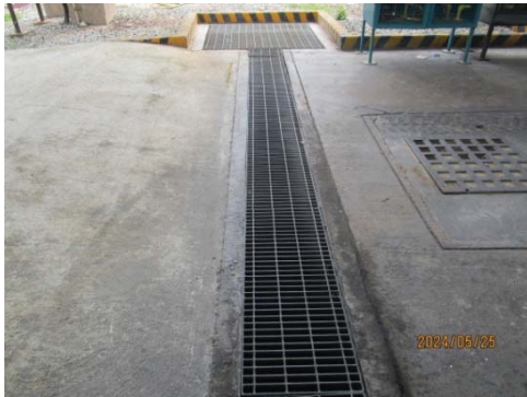
รูปที่ 3.1-1 (รูปที่ 11 Surface Water Sewer (SWS))
