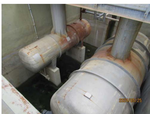
รูปที่ 3.1-1 (รูปที่ 9 Close Aromatics Drain (CAD) พื้นที่สาขาที่ 4)
