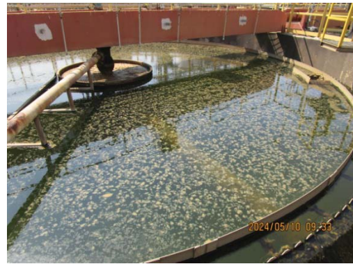
รูปที่ 3.1-1 (รูปที่ 24 Clarifiers)
