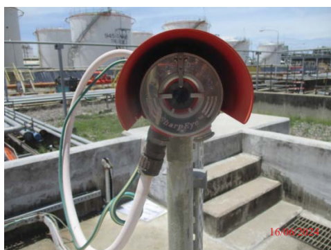
รูปที่ 3.1-1 (รูปที่ 67 Flame Detector)
